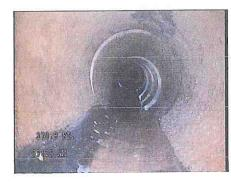
3+77 JOINT OFFSET (THREE IN A ROW) - PIPE ROUND 3+84 JOINT OFFSET, SOIL VISIBLE IN GAP - PIPE ROUND 3+86 JOINT OFFSET, SOIL VISIBLE IN GAP (TWO IN A ROW) - PIPE ROUND
